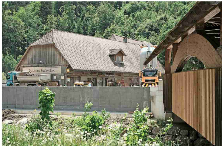
Die Stützmauer soll den Landgasthof davor bewahren, dass die Emme bei einem nächsten Hochwasser erneut auf sein Areal eindringt.
